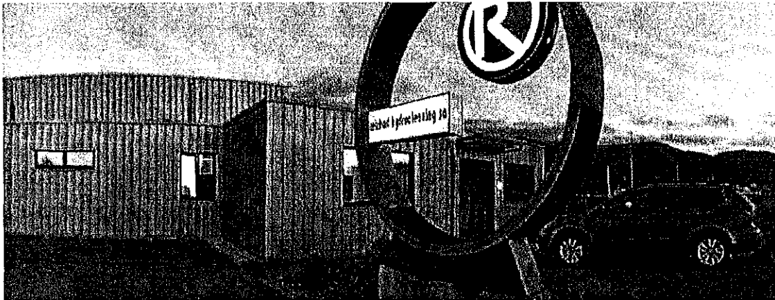
A l'usine de Courroux, une nouvelle halle permet de tester le matériel en grandeur nature et bien sûr de convaincre la clientèle.
